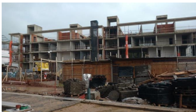
FIGURA 6. VISTA DEL CONJUNTO NUEVO EN CONSTRUCCIÓN
