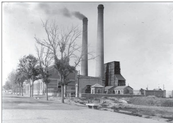
FIG. 6. Panorámica de la Fábrica de la Luz de Cartagena desde la Alameda de San Antón. Año 1915. Fuente: Archivo General de la Región de Murcia.
