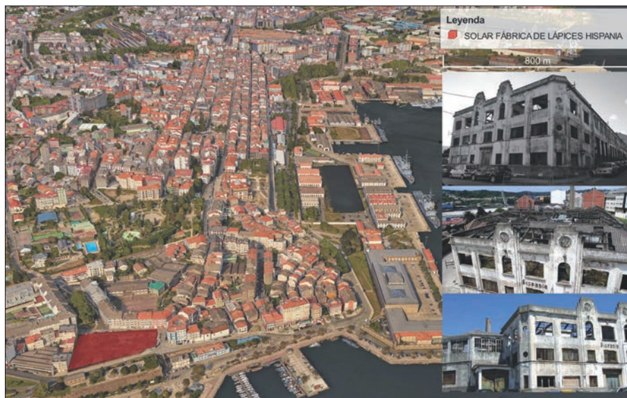
FIG. 9. Vista general del solar urbano resultante tras el derribo, en el año 2012, de la antigua Fábrica de Lápices Hispania en la ciudad de Ferrol. Año 2016. Elaboración propia a partir de Ortoimagen Espacial Google Earth 2016 y fotografías obtenidas de < www.lavozdegalicia.es >.
