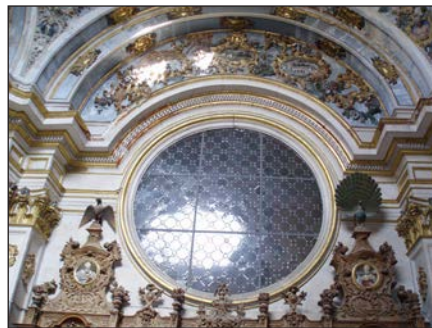
Fig 7. Coronación de la cajonería del costado norte de la sacristía
