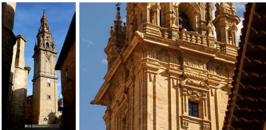
Figura 5. CATEDRAL DE SANTO DOMINGO DE LA CALZADA
